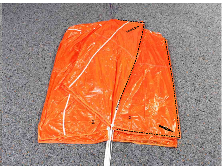
12. Bahn 2 legen und den oberen Teil der Bahn 1 seitlich herausziehen.
